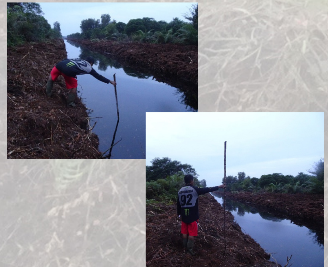
Tim melakukan pengukuran kanal yang baru dibuat menggunakan sebatang kayu untuk memastikan kedalaman kanal. Foto diambil pada titik koordinat N0^{\circ}39'26.58'' E102^{\circ}4'34.92'' tanggal 28 Juli 2020 @ Jikalahari.
