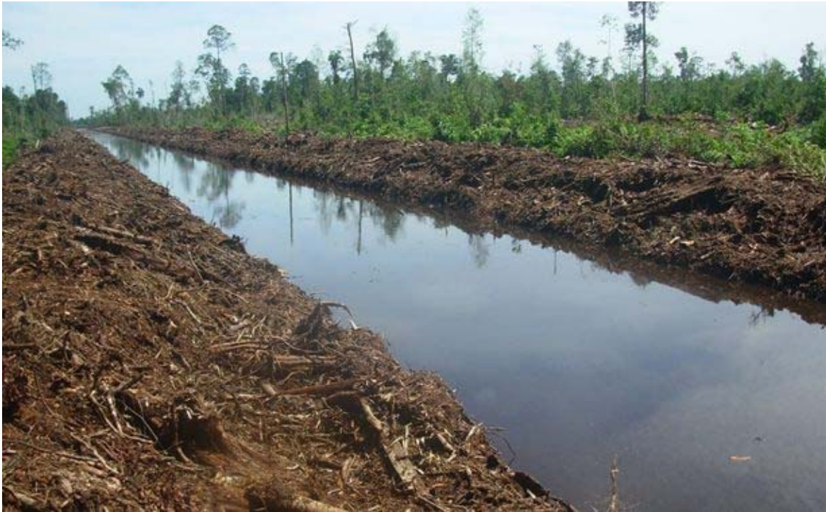
Foto 3. PT SRL menggali kanal gambut di hutan Kerumutan dengan titik koordinat S.00 24 38.7 102 46 30.8 yang menyebabkan emisi CO 2 signifikan.
